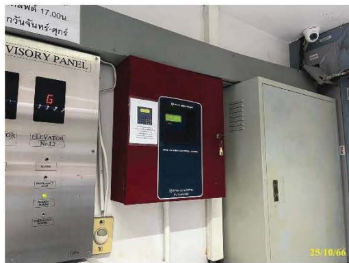
แผงควบคุมระบบสัญญาณแจ้งเหตุเพลิงไหม้ (FCP)
